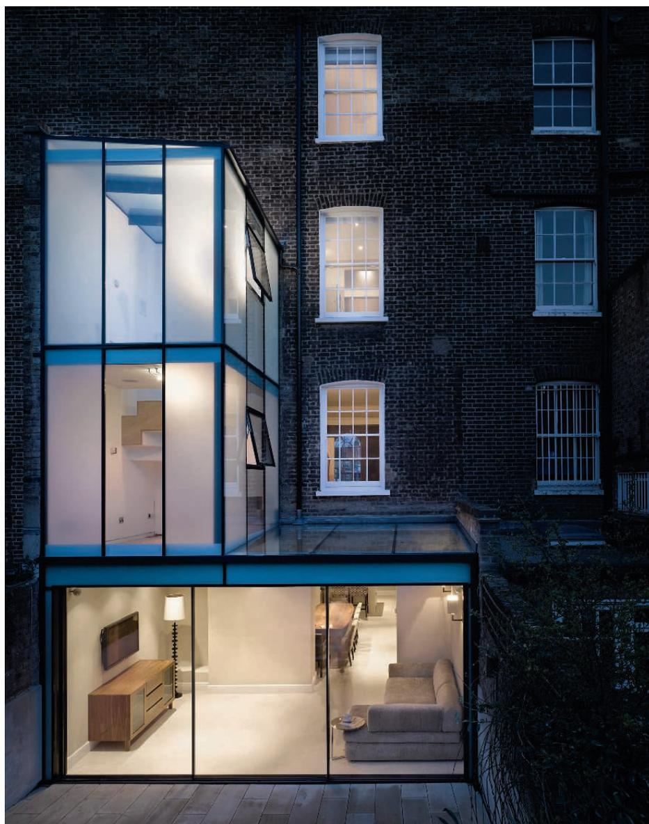
**Guard di Sky-Frame.** Finestra di ampio respiro, scorrevole con profilo in alluminio verniciato nero, superficie di protezione contro l'effrazione, sistema di chiusura su più punti dotato di sensori di allerta integrati. Su richiesta può avere anche vetri di sicurezza stratificati. [wiffa.it](http://wiffa.it)
